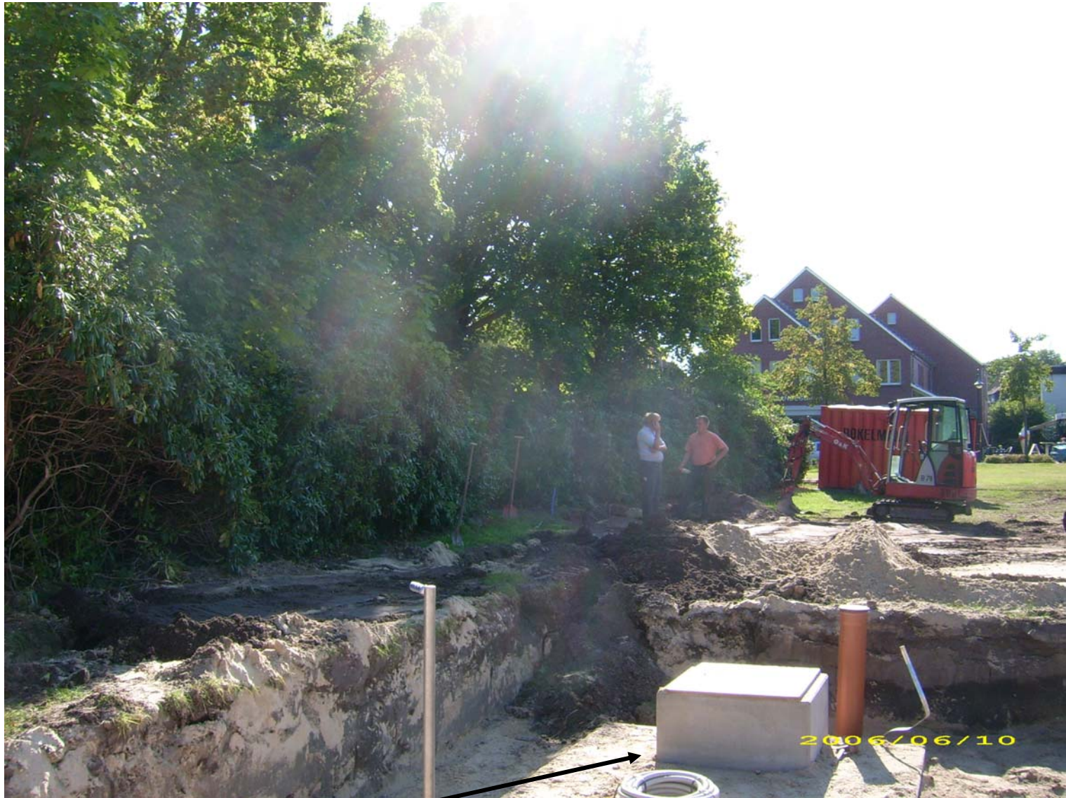
Im Vordergrund die Pumpenkammer des Brunnenanlage
