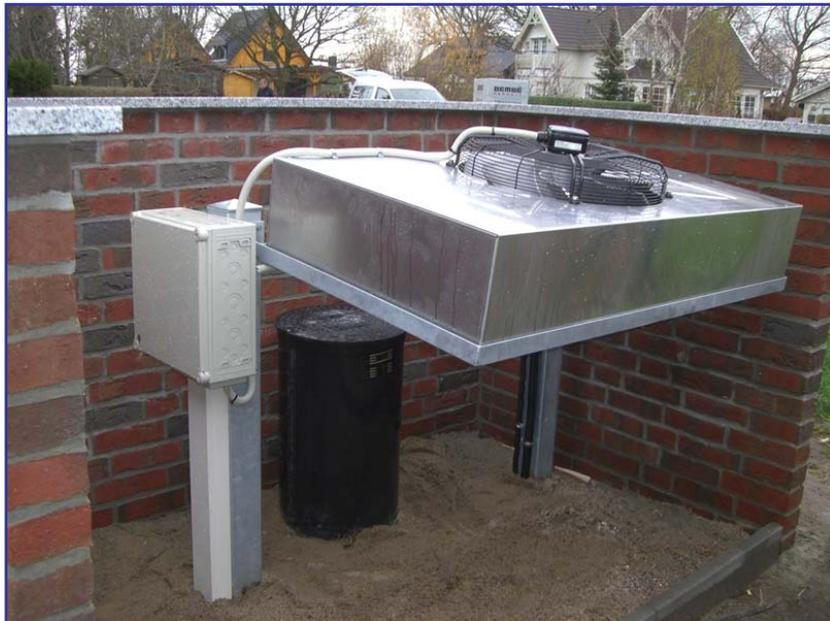
Beispielhafte Darstellung einer Luftwärmepumpe
