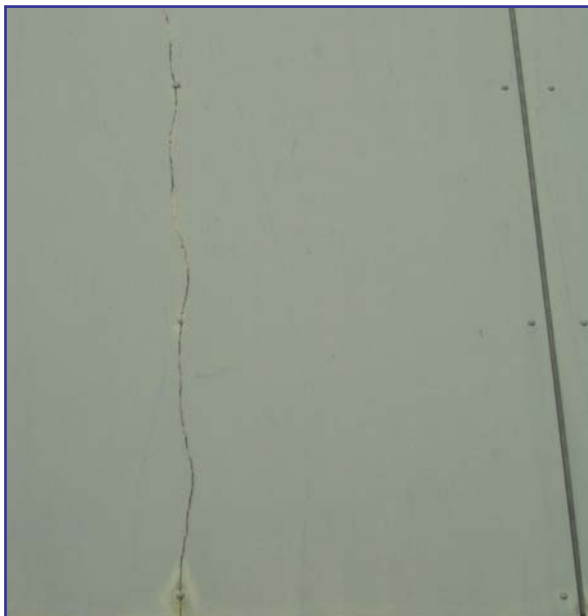
Risse der Verkleidung deutlich zu erkennen!
