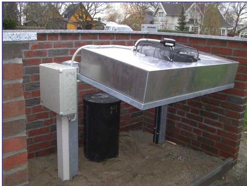
Beispielhafte Darstellung einer Luftwärmepumpe
