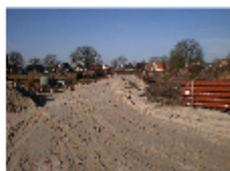
Die Arbeiten für die Erschließung des neuen Baugebietes „Südlich Schlosspark II“ sind inzwischen schon recht weit vorangeschritten. In einem ersten Abschnitt wurde zunächst der Regenwasser- und der Schmutzwasserkanal verlegt sowie das Regenrückhaltebecken ausgehoben. Kurzfristig erfolgt jetzt eine Sperrung des Loyer Weges im dortigen Bereich, um auch hier Kanalleitungen zu verlegen. Die Bauarbeiten sollen bei guter Witterung bis Mitte Juni abgeschlossen sein.
