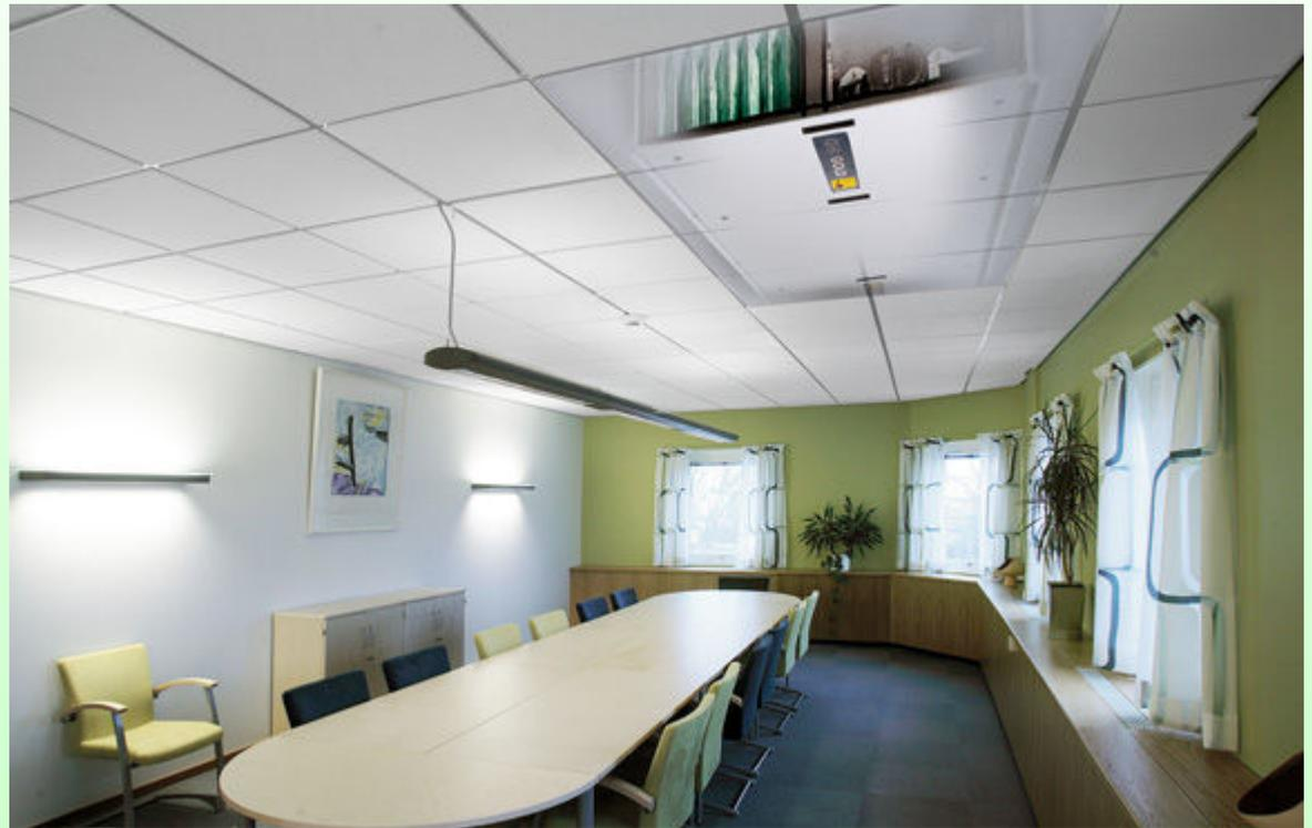
Wärmerückgewinnungsgrad im Wärmetauscher  $\eta \geq 80\%$
