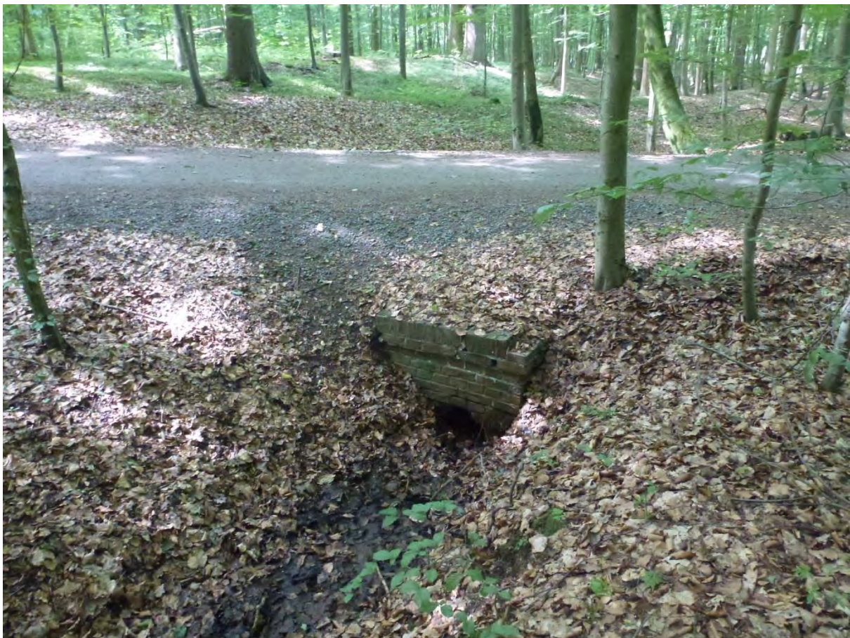
Abb. 52: Historisches Durchlassbauwerk über den Wegeverlauf an der „Wolfsschlucht“. (v. Hoeren; 2017)
