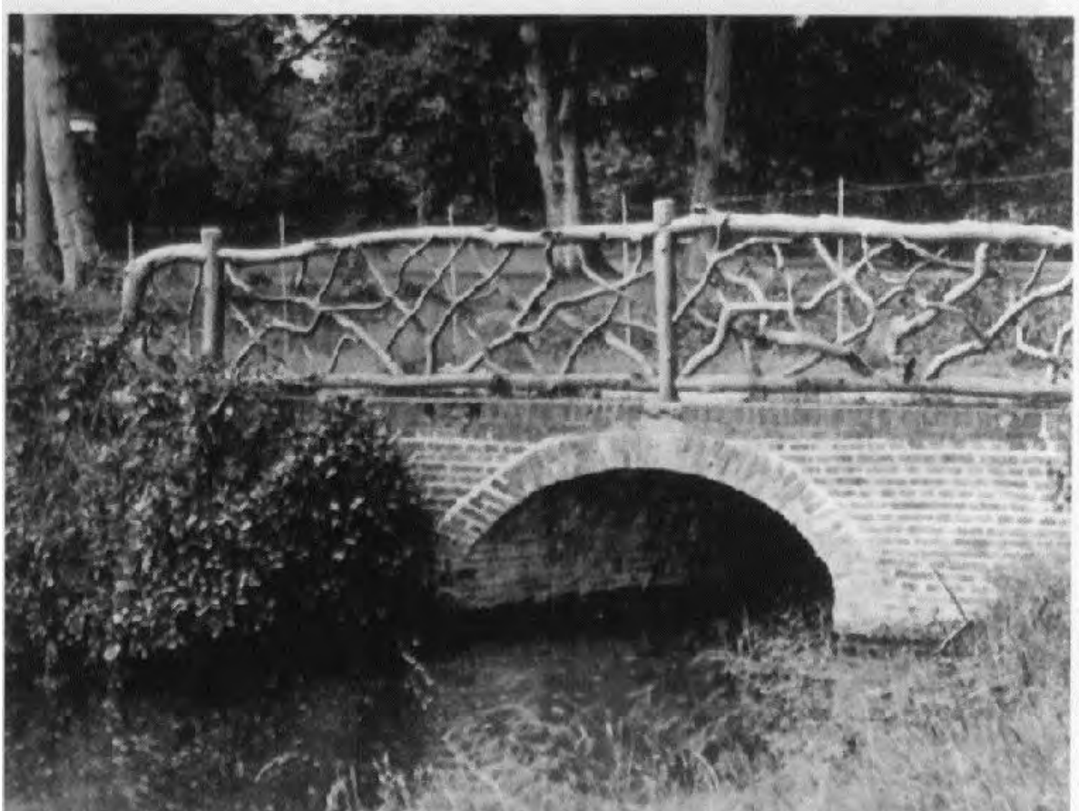
Abb. 12: Massive Ziegelbrücke mit Geländer aus Knüppelholz über die Bäke. Aufnahme um 1900. (Gemeindearchiv Rastede, Bildgutsammlung)
