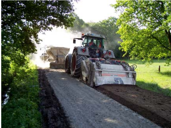
Das Aufbruchgut wird mit Zement und zusätzlichem Mineralgemisch aufgearbeitet.
