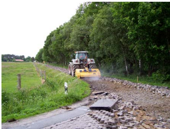
... anschließend mit einem Brecher zertrümmert.
