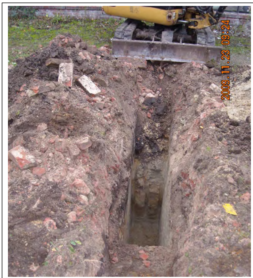
Bild 7: Schurf 8, Wegebereich zwischen Gewächshäusern mit Bauschutteinlagerungen
