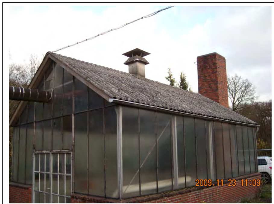
Bild 17: Wellzementeindeckung Heizungsgebäude Einfahrtsbereich
