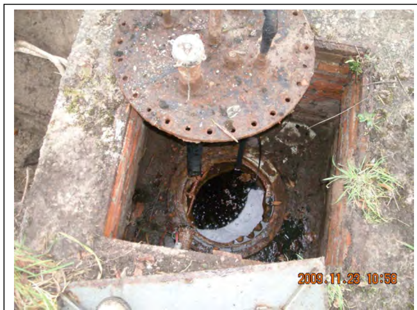
Bild 13: Domschacht Erdtank vor Gewächshäusern
