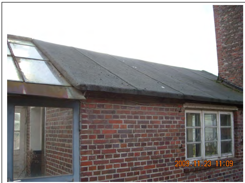
Bild 19: Bitumendachbahnen Heizungsgebäude Einfahrtsbereich
