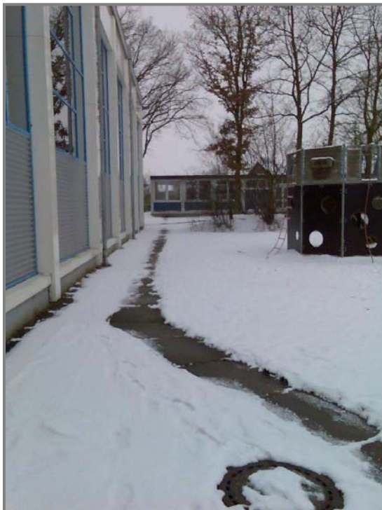
Verlauf der alten, schlecht isolierten Fernwärmeleitung!
