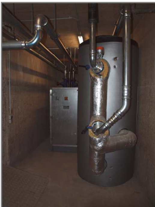
Wärmetauscher (Abluft) während der Einbauphase August 2012
