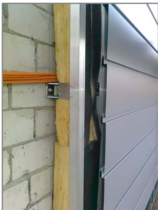
Aufbau der neuen Attikaverkleidung
