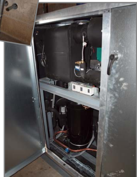
Wärmetauscher (Abluft) während der Einbauphase August 2012
