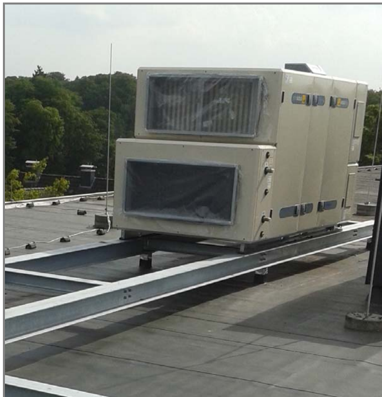
Neues Lüftungsgerät auf dem Dach (Thoradestraße) der KGS
