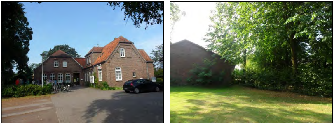
Abb.: Bestandssituation Dorfgemeinschaftshaus in Nethen
