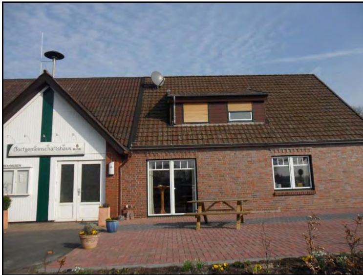
Abb.: Bestandssituation Dorfgemeinschaftshaus in Bekhausen
