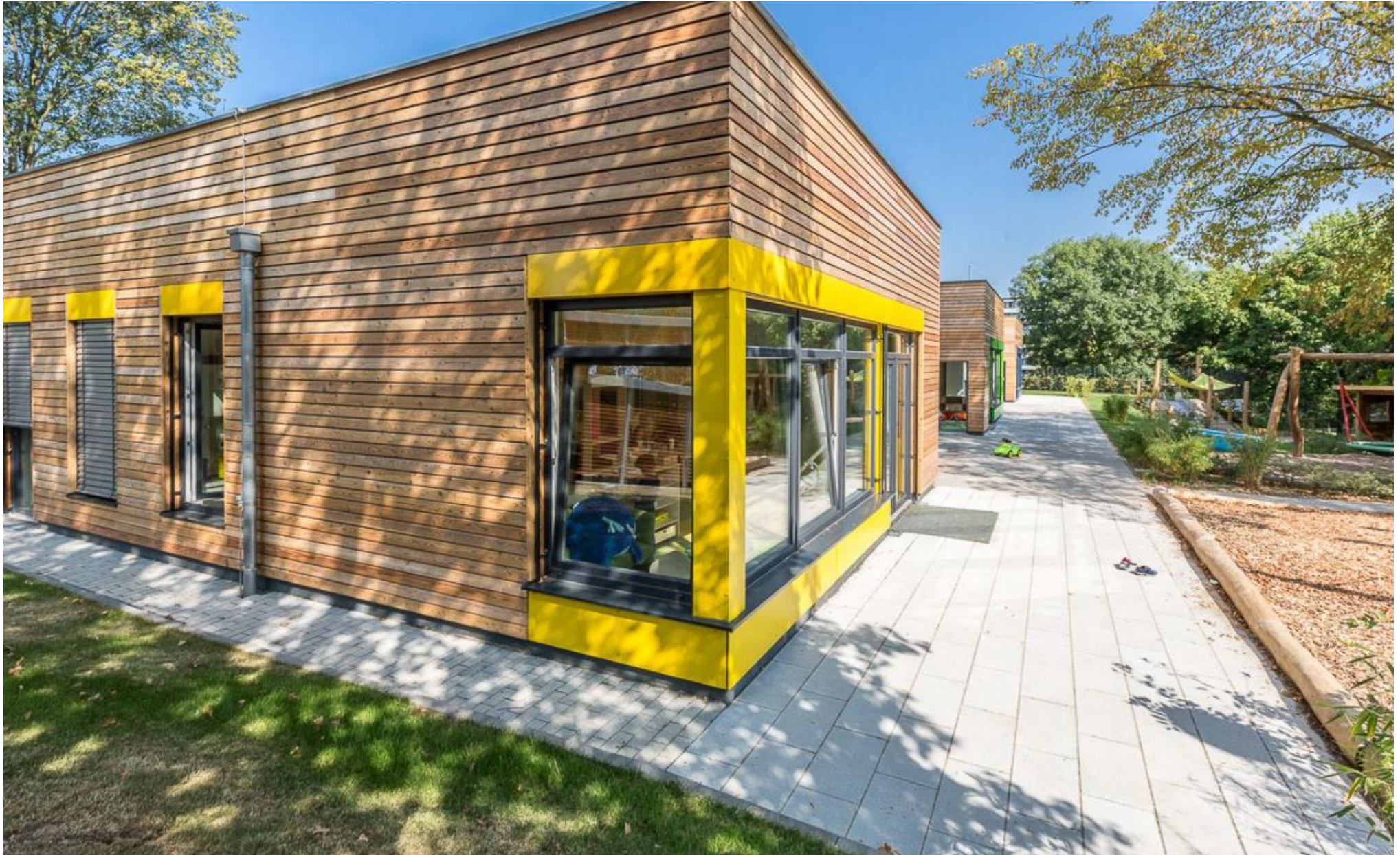
Fassade: Sibirische Lärche
