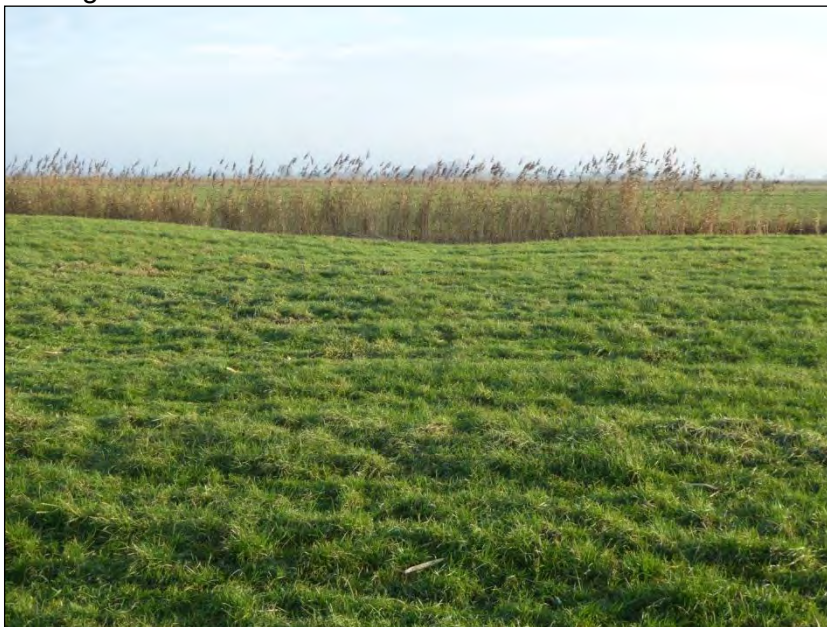
Abb. 26: Das Gelände weist Senken mit einer Tiefe bis 0,3 m auf.
