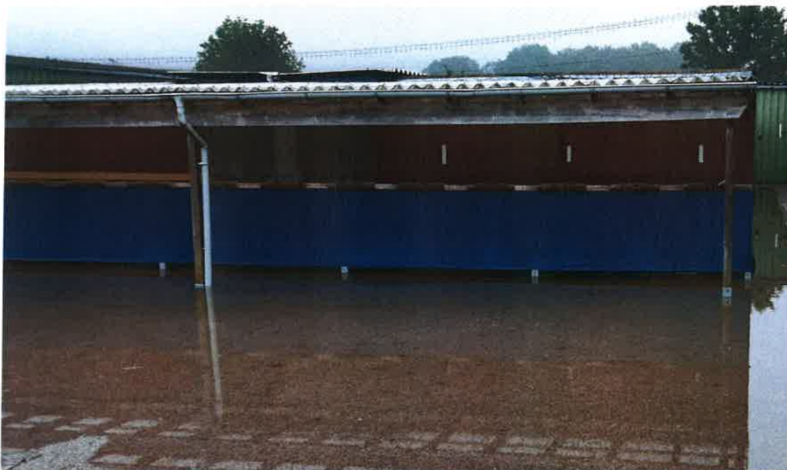
Bild 8: Innenbereich der Zuchtanlage
