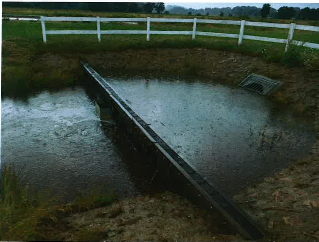
Abbildung 4: Wasserstand im Regenrückhaltebecken am 27.06.2020
