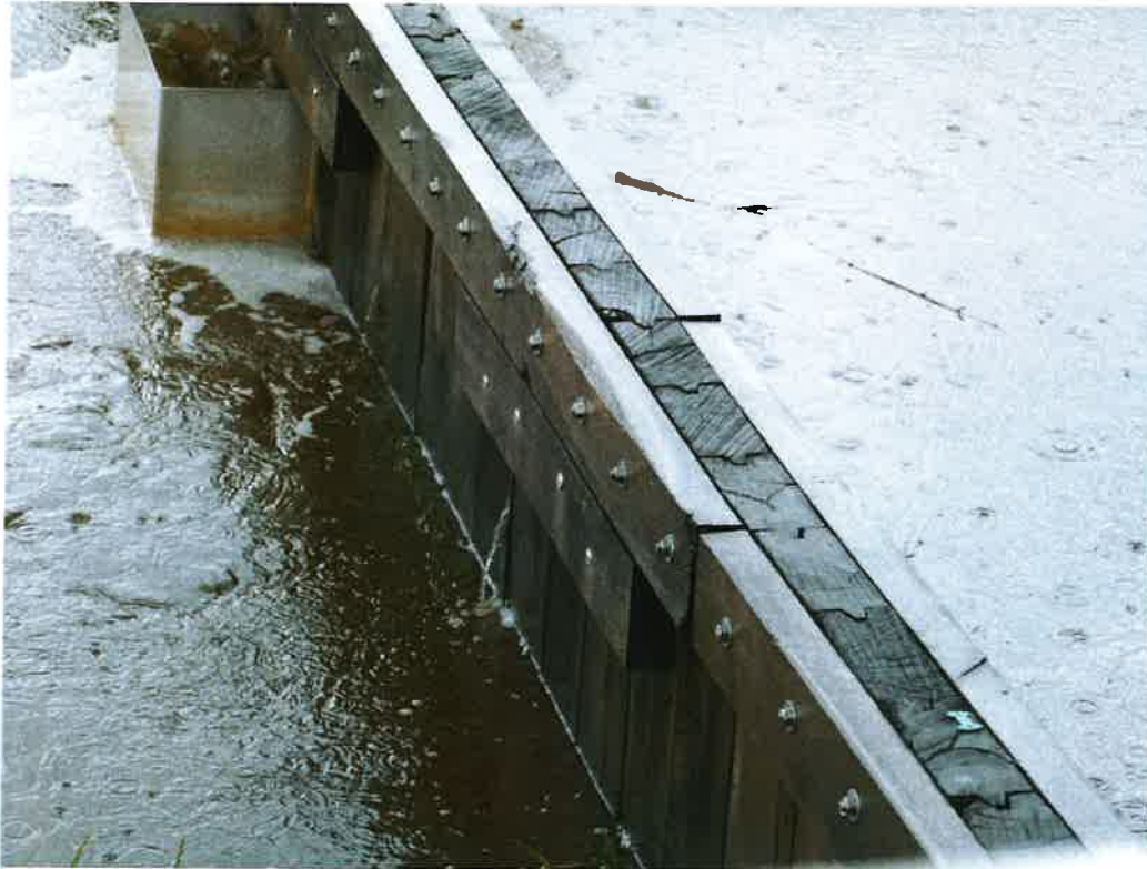
Abbildung 3: Wasserstand im Regenrückhaltebecken am 27.06.2020
