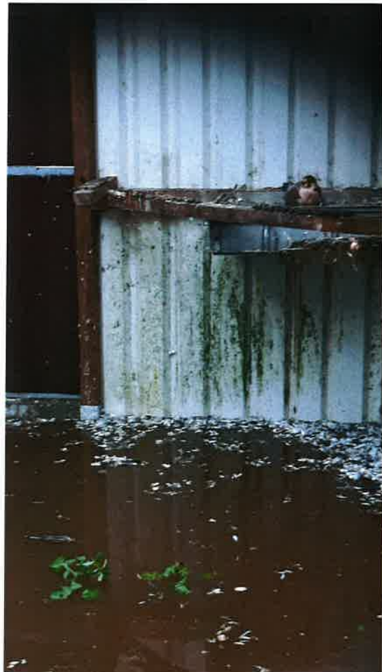
Bild 7: Überflutung der Zuchtvolieren
