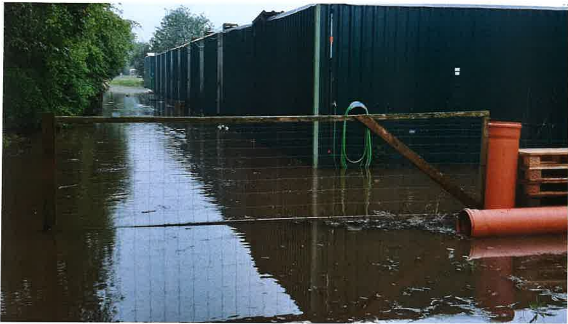
Bild 5: Überflutung im rückwärtigen Grundstücksbereich (Zuchtanlage)
