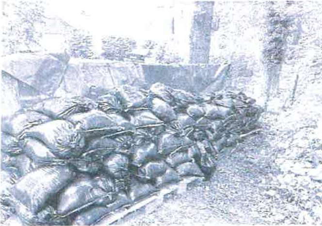
Sollen künftig Schutz bieten bei Überschwemmungen: 175 Sandsäcke wurden von Anliegern des Koppelwegs gefüllt und vorbereitet.
