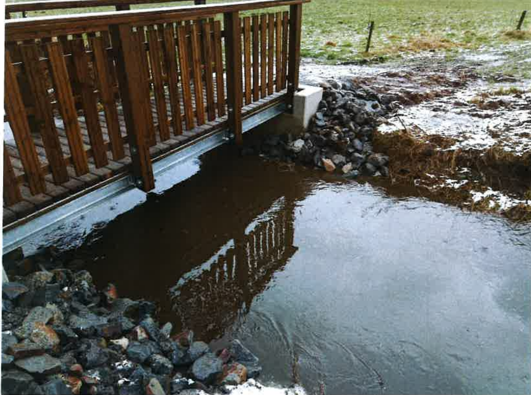
Bild Nr.6 Neue Fußgängerbrücke unterhalb der Einleitstelle aus dem neuen RRB
