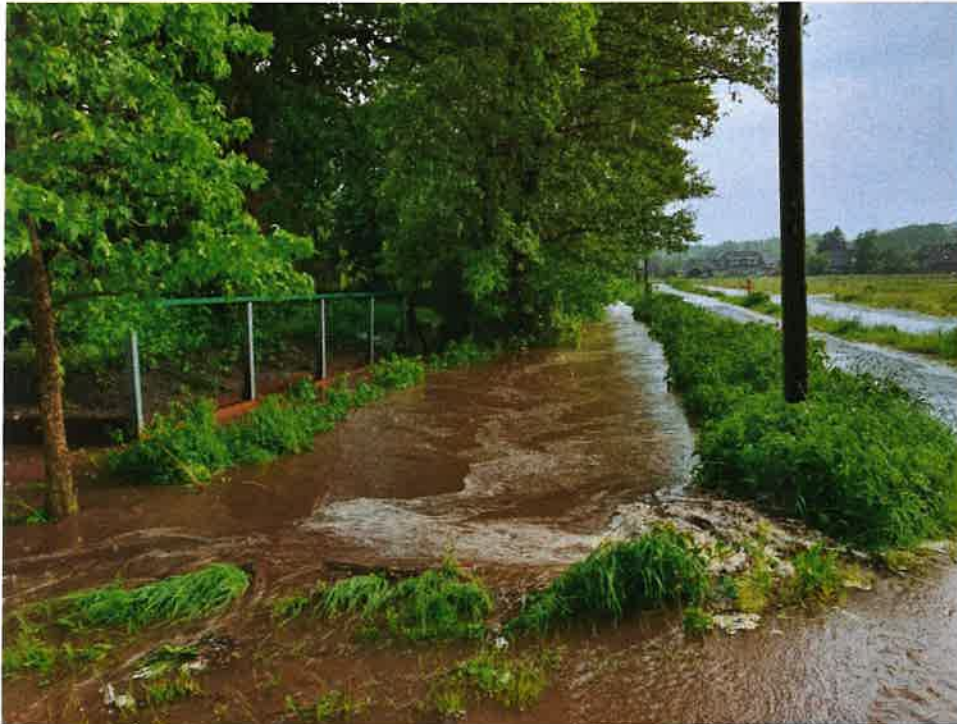
Bild 1: Überstauung der Rohrleitung DN 1000 im Zufahrtsbereich
