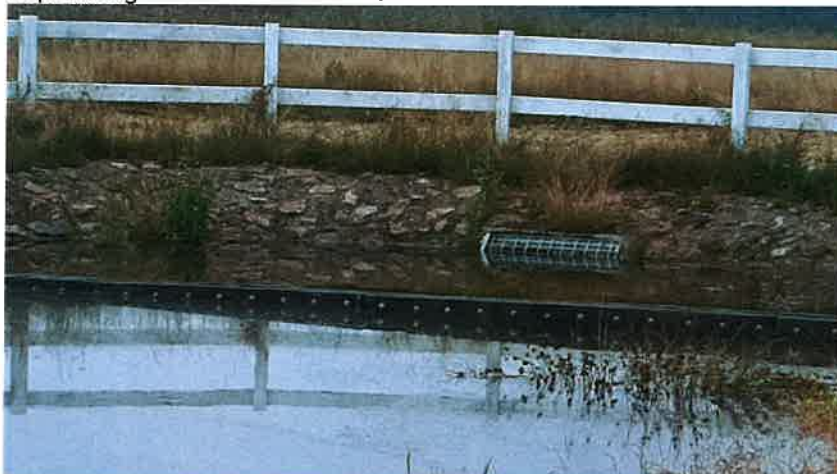
Bäke im weiteren Verlauf nach „Baustelle“
