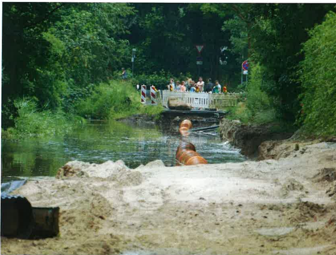
Abbildung 2: Hankhauser Bäche, Ausbauabschnitt, Blickrichtung Mühlenstraße am 27.06.2020
