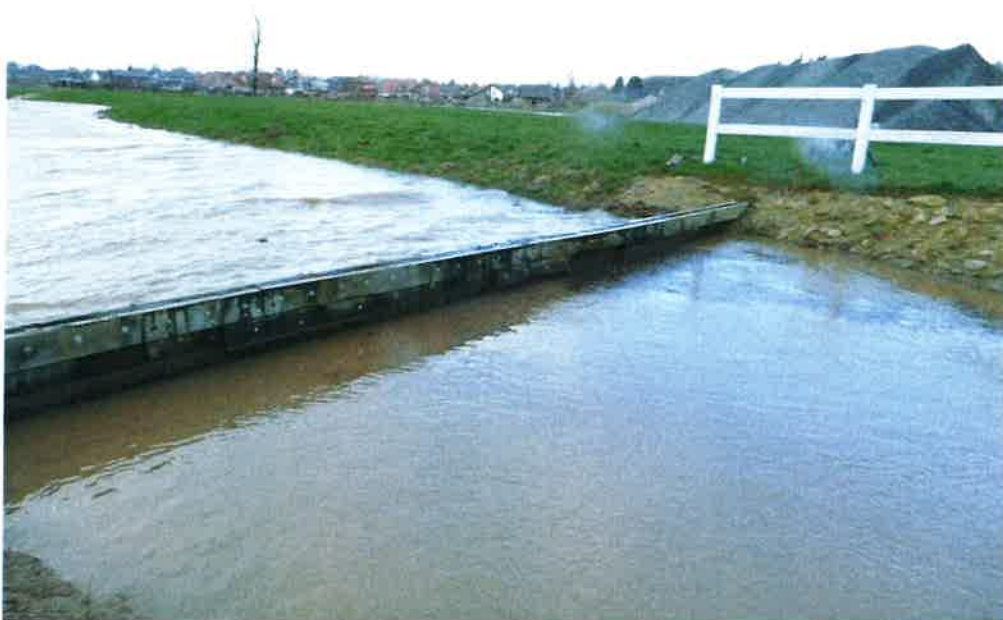
Abbildung 6: Wasserstand im Regenrückhaltebecken am 25.02.2020
