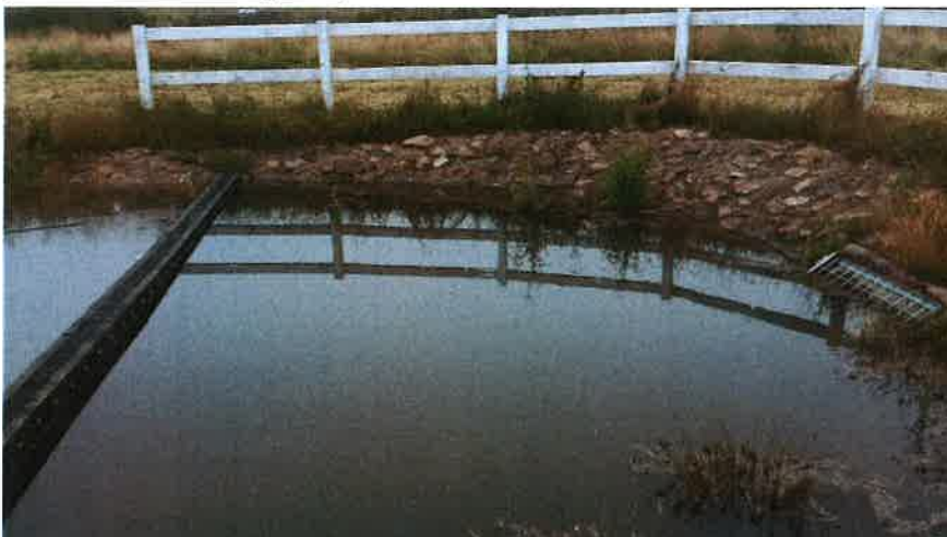
Auslaufbereich des RRB am 15. Juli 2021
