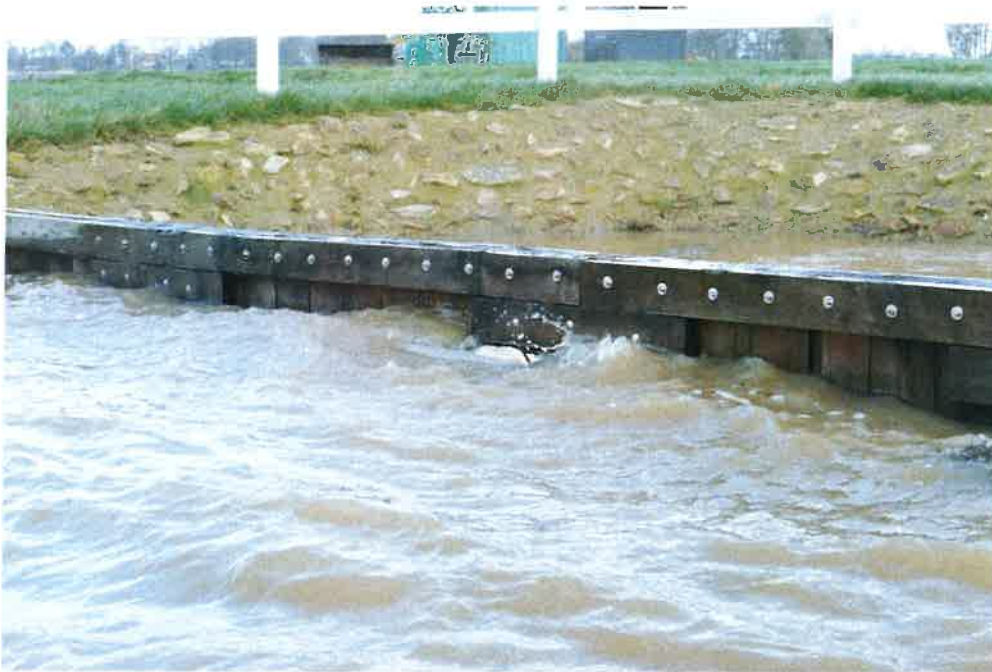
Abbildung 5: Wasserstand im Regenrückhaltebecken am 25.02.2020
