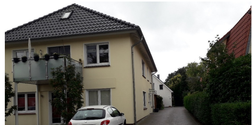
Zufahrten auf die rückwärtigen Grundstücksbereiche an der Anton-Günther-Straße
