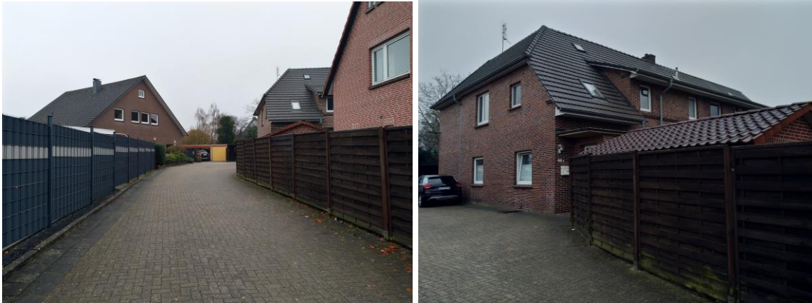
rückwärtige Bebauung im nördlichen Geltungsbereich
