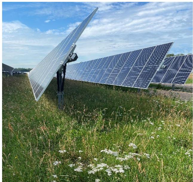
Abbildung 2: Nachgeführte Solarmodule Solarpark Lottorf
