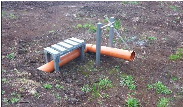
Abbildung 1: Gegen unsachgemäße Verstellung gesichertes, regelbares Überlaufrohr in einem frisch hergerichteten Polder.
