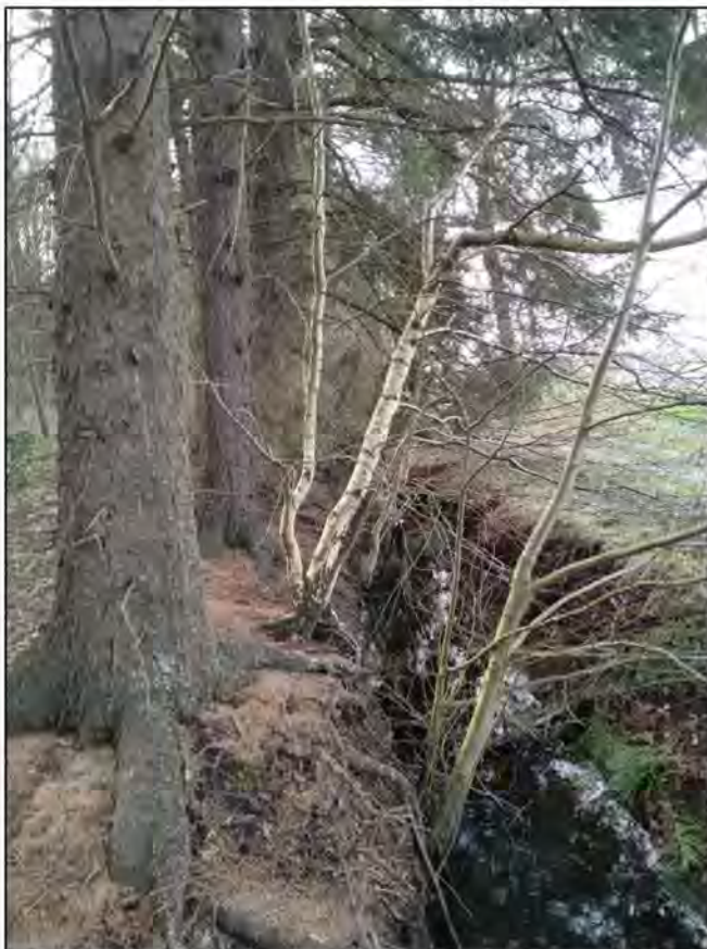
Abbildung 26: Westlicher, wegbegleitender Graben mit Blick von Nord nach Südwest; grabenbegleitende Fichtenreihe.
