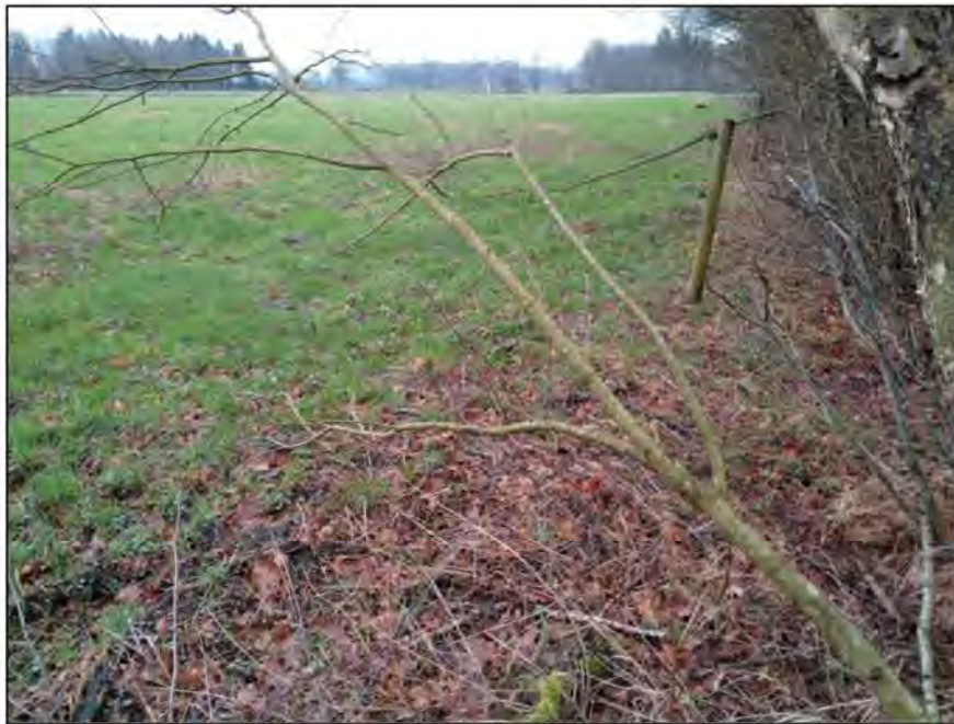
Abbildung 84: Verfallener Graben entlang der westlichen Längsseite der Projektfläche bei Bohrpunkt 130 mit Blick nach Südost
