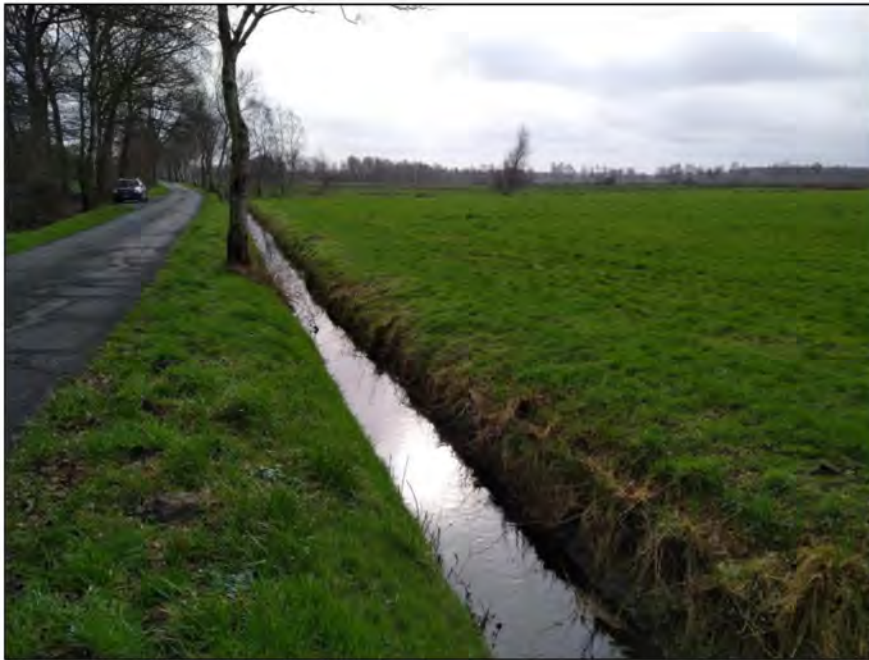
Abbildung 92: Straßenbegleitender Graben an der nordöstlichen Grenze der Projektfläche mit Blick nach Südost, links Kolonatsweg
