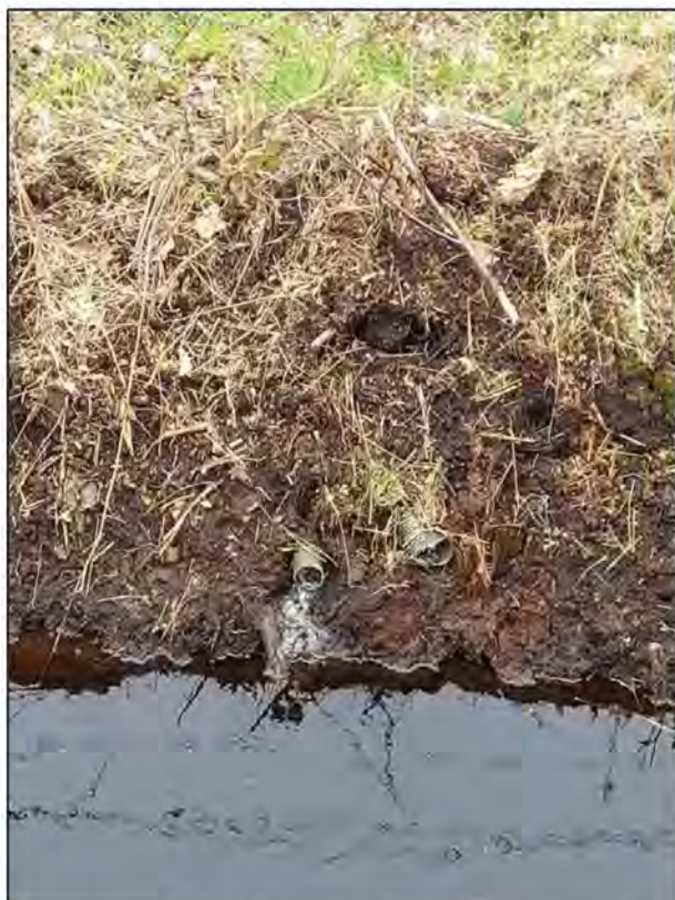
Abbildung 111: Einleitung einer Drainage in den straßenbegleitenden Graben am Deelenweg
