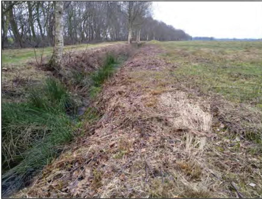
Abbildung 54: Östlicher Straßenrandgraben mit Blick von BP 94 Richtung Südost.
