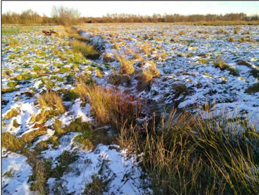
Abbildung 36: Mittelgraben mit verfallener Überfahrt.
