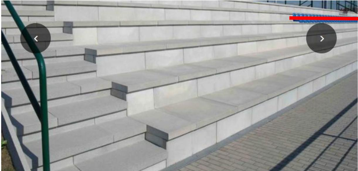
*Abb. 6: Quelle Grafe Beton. Die Verwendung von Sitzschalen ist nicht vorgesehen. Lediglich eine farblich dunkle Holzbelattung ist aufzubringen. Ferner ist der Beton werkseitig dunkel einzufärben.*
