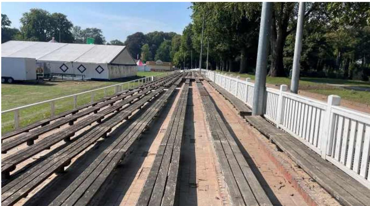
Abb. 4: Tribünenbereich mit erkennbaren Belagsschäden durch Wurzelhebung der benachbarten Gehölze. v. Hoeren August 2024.
