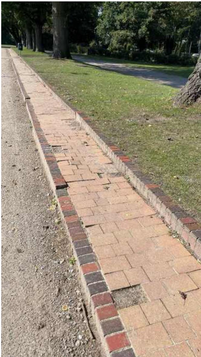
*Abb. 3: Stufenanlage im rückwärtigen Tribünenbereich mit deutlich erkennbaren Hebungen und Zerstörungen durch oberflächenzonales Wurzelwerk der Bestandsgehölze. V. Hoeren, 08 2024.*
