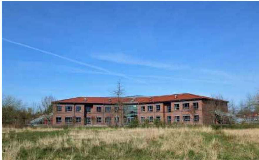
Neubau Grundschule Moordorf
